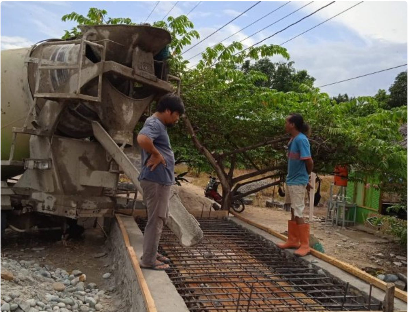
Pembangunan Plat Duicker Desa Mario, Kab. Luwu Utara
